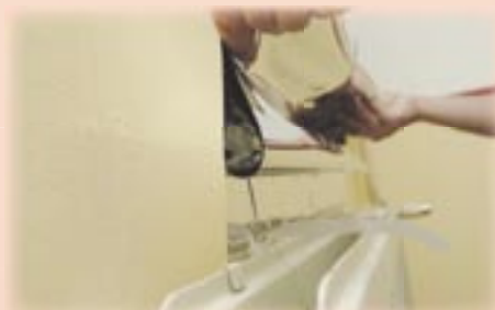
10. Trek de folie strak en plak die op de bovenste rand van de radiator.
