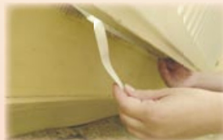
9. Plak de onderkant van de folie op de onderrand van de radiator.
